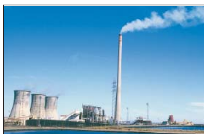
CENTRAL TÉRMICA DE CARBÓN
